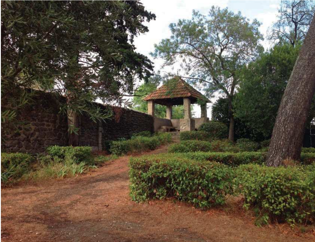
Mur d'enceinte et petit belvédère ou poste de guet (cl. AAC).
