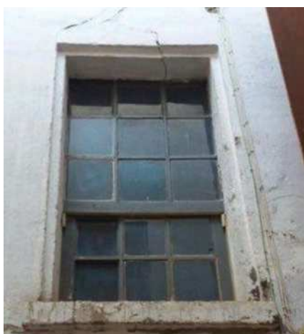
Fenêtre à guillotine fermée 36 rue Anatole France.
