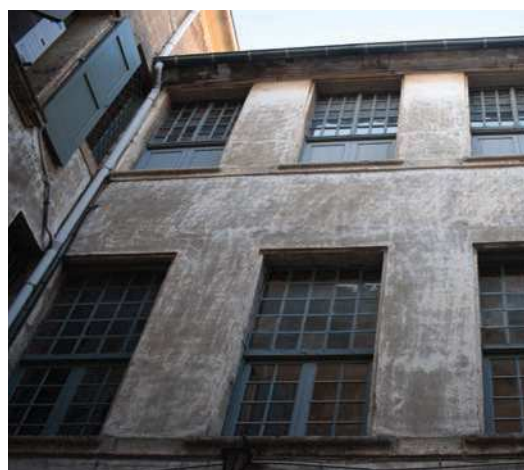
Fenêtres, 14 cours Jean-Jaurès.
