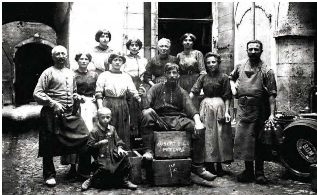
Marcel, fils de Jules et le personnel de l'entreprise, dans la 1 re cour. A gauche, au fond de l'image, le portail de l'entrepôt qui occupait la seconde cour, face à la loggia.
