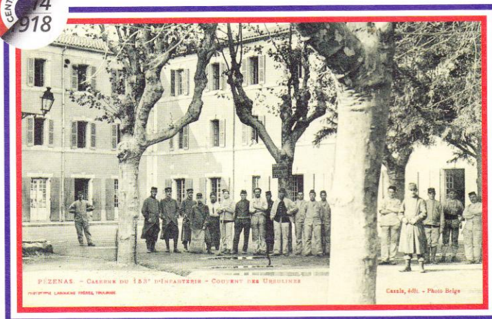
L'ancien couvent des Ursulines, route de Castelnaud-de-Guers, transformé en caserne durant le conflit.
