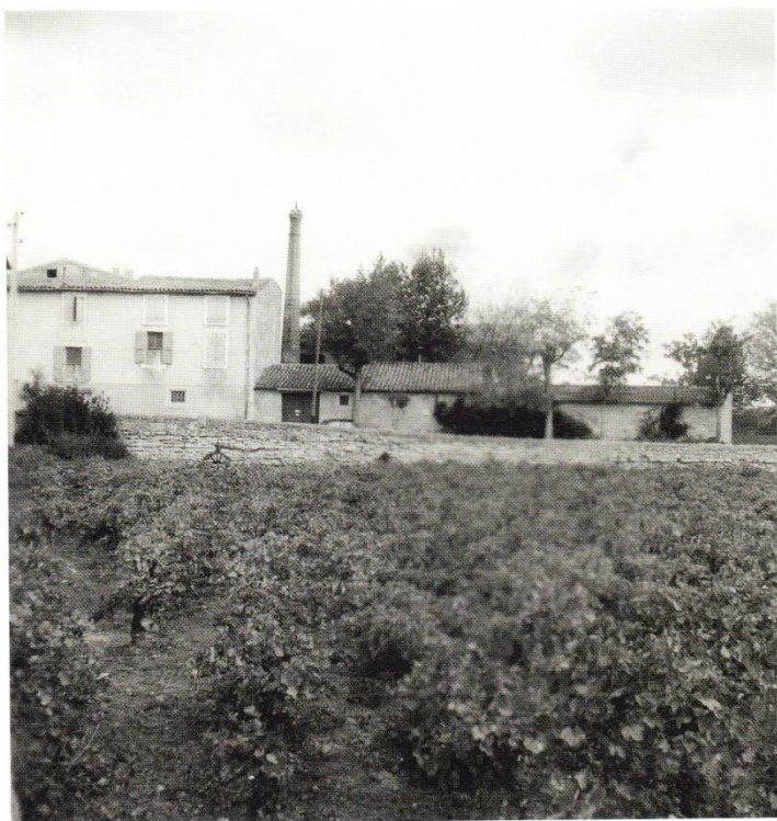
Les bâtiments de la fonderie en bord de Peyne.
